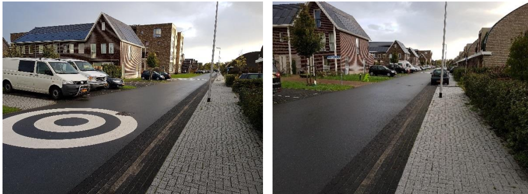
Afbeelding 2-5 Attentieverhogende maatregelen Rodenbergse Dreef
