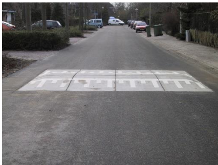
Afbeelding 4-2 Snelheidsremmende maatregel: drempelconstructie en punaise
